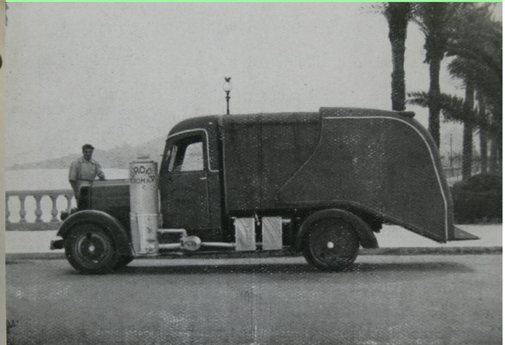
Trasformazione a gassogeno Autocarro Municipio di Tripoli
