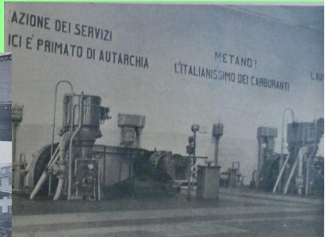
Fig. 12. — Interno della centrale di compressione « A.T.M. » con apparecchiatura elettrica e motori antideflagranti.
